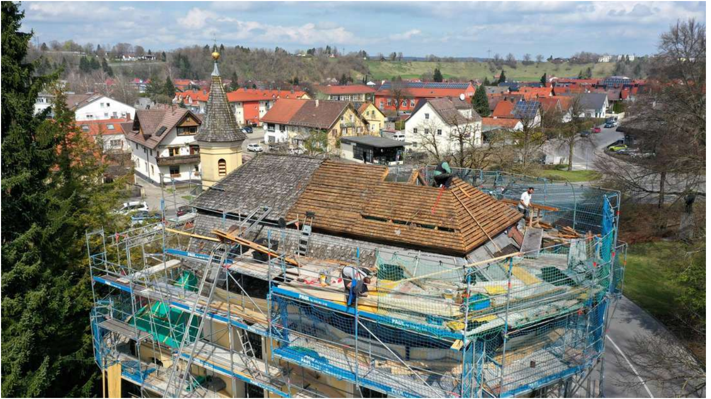
Das komplette Dach der Heilig-Kreuz-Kapelle bekommt neue Holzschindeln. Auch ein Maueranker muss eingezogen werden. © Hans-Helmut Herold
