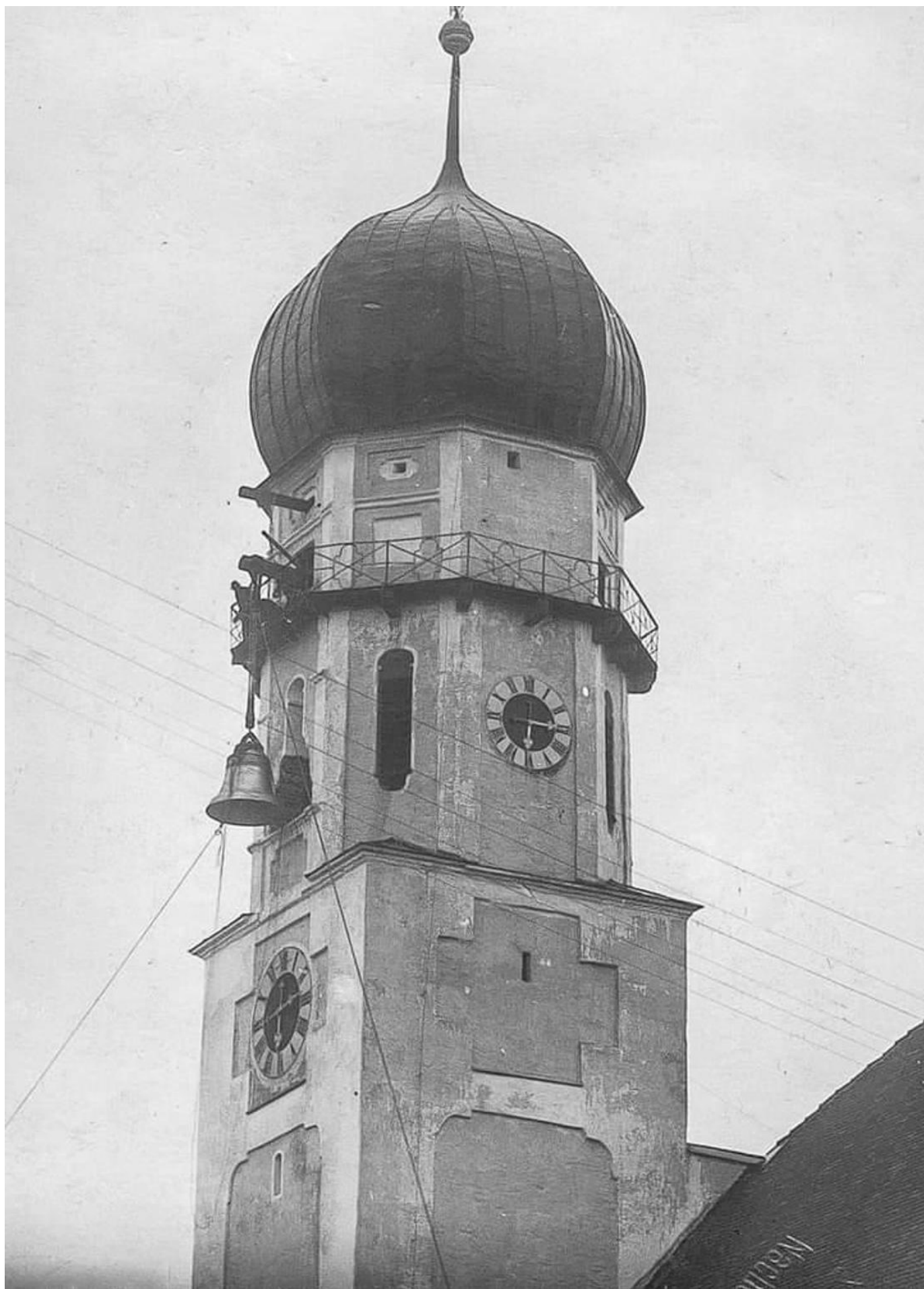
Glockenaufzug 1914: Heute benötigt man vermutlich einen Schwerlastkran. © Pfarrei Mariae Himmelfahrt
